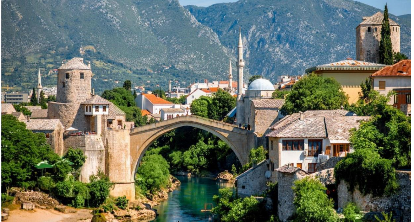
PONT DE MOSTAR (© RH2010 @CC · MOSTAR - HERZEGOVINA-NERETVA)
